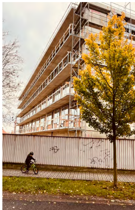
Bytové domy Comax ve výstavbě
