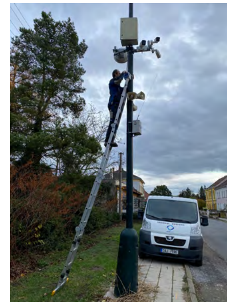
Instalace senzorů měření kvality ovzduší
