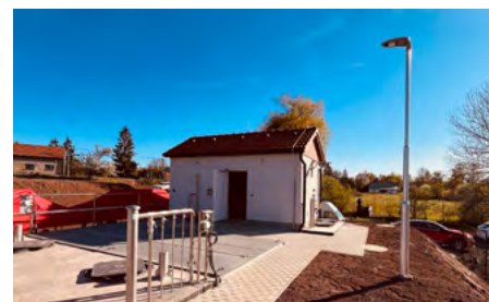
Ješínská čistička zaručuje, že voda do potoka už teče krásně čistá
