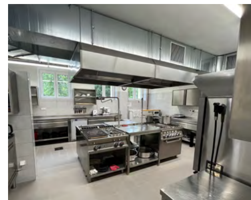
MŠ je komplet opravená, včetně moderní kuchyně
