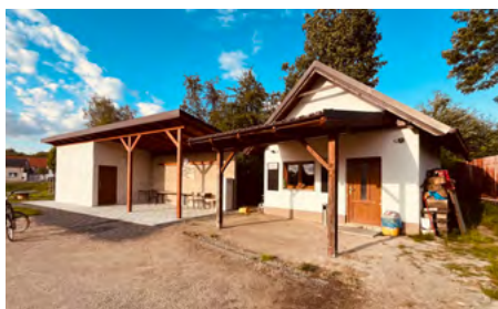
Zázemí pro komunitní akce na Bučině těsně před dokončením
