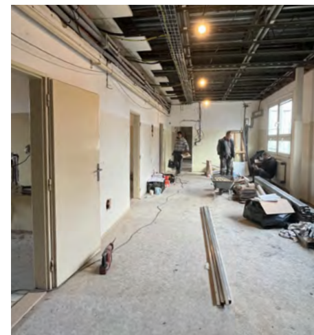
Zdravotní středisko v průběhu přestavby
