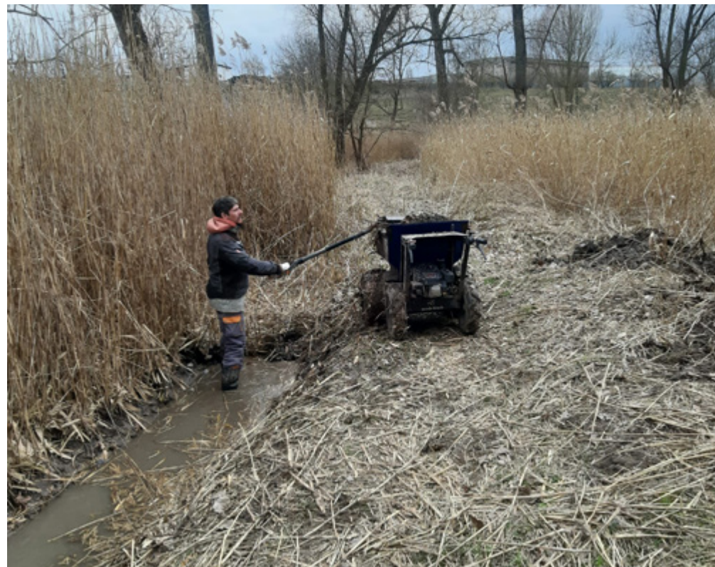
práce na rekonstrukci náhonu „za Kačákem“ - březen 2021, foto K. Špičková
