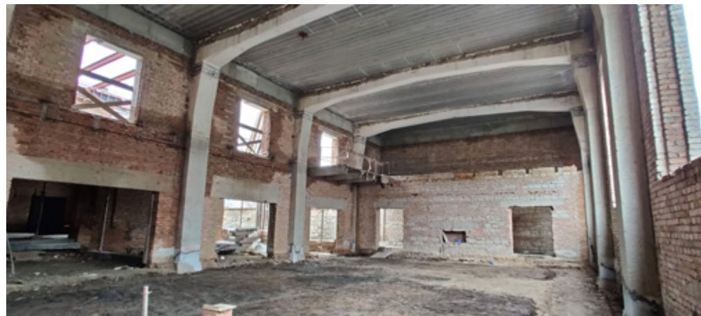
Nový strop nad sálem už je hotov - vydrží i když budeme tancovat dupáka, klidně na střeše
