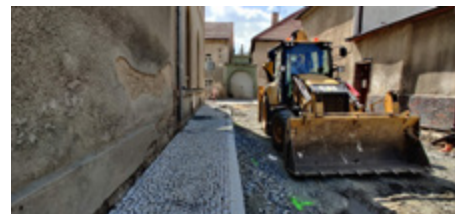
Chodníky v Růžové ulici už se rýsují
