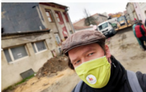
Kontrolní dny na stavbách jediň s rouškou
