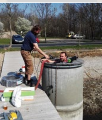
Do skruže s čerpadly byly namontovány UV lampy
