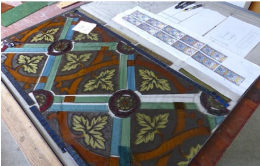
Proces restaurování vitráže je dosti složitý, musí se měřit, překreslovat, počítat, ořezávat, zkoušet barvy, omývat, vypékat, dokumentovat, tmelit...
