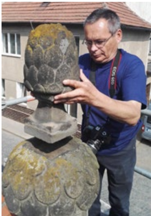
Pan Plachý snímá kamennou šišťici z chržínské branky - nebyla vůbec připevněná
