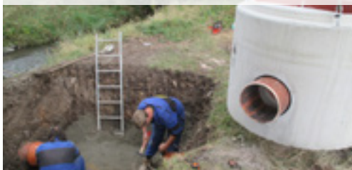
Instalace nové šachty u náhonu
