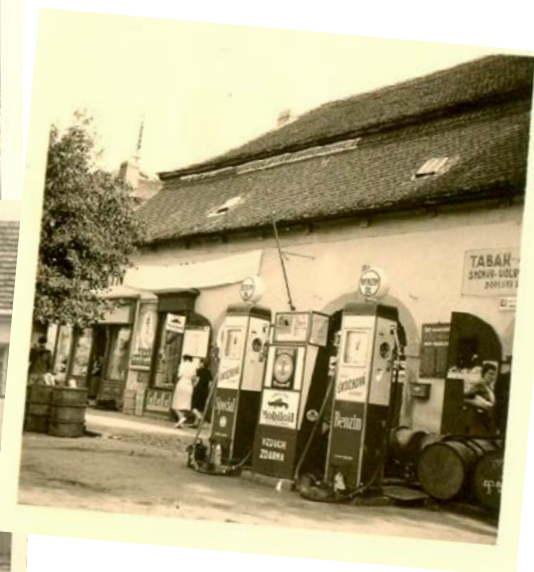
Foto 1: Dvůr domu čp. 112
