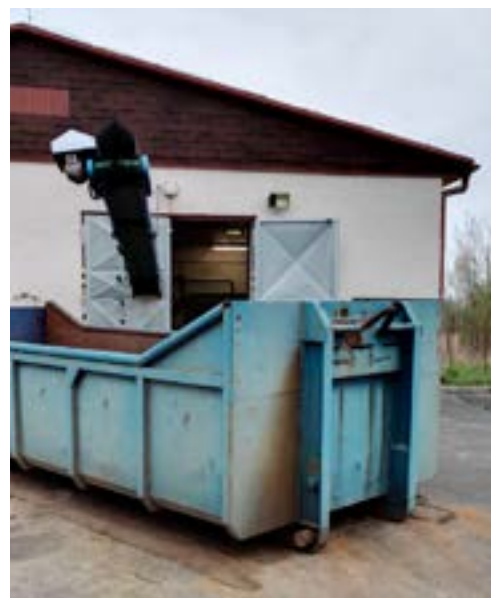
Velvarskou čistírnu odpadních vod provozuje město
