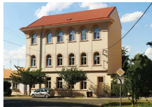
Budova školní družiny prošla celkovou opravou
