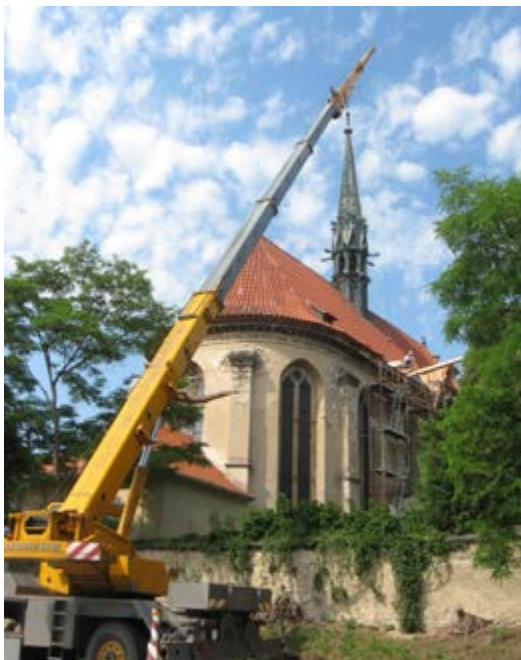
Oprava sanktusní věže v roce 2013
