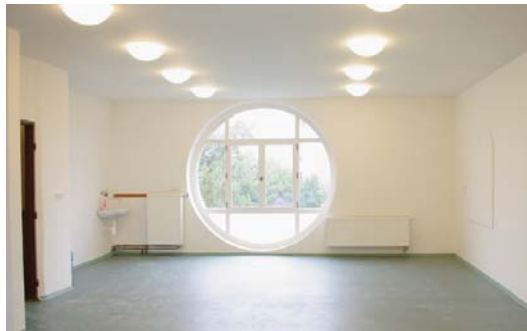
sál v prvním patře Kostky po rekonstrukci
